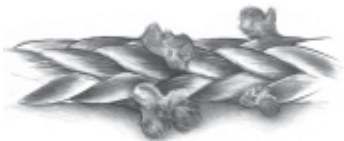
El cable muestra dos hilos adyacentes cortados: deberá reemplazarse el cable
